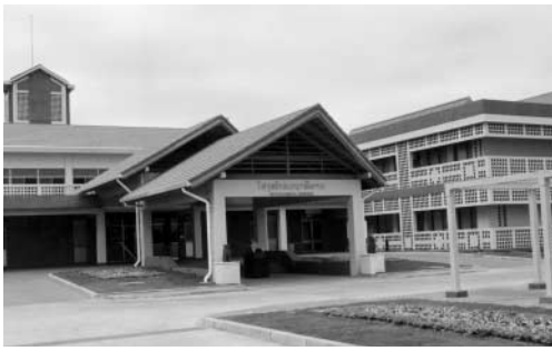
セタティラート病院外観
